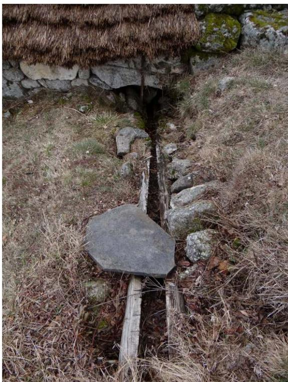
Pont-de-Montvert-Sud-Mont-Lozère (Lozère), Finiels ; détail d'un tronc évidé servant de canalisation d'arrivée d'eau.
